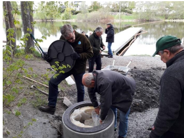
Thor innreder brønnhuset.
